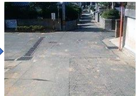
短期間で通行可能になった道路
